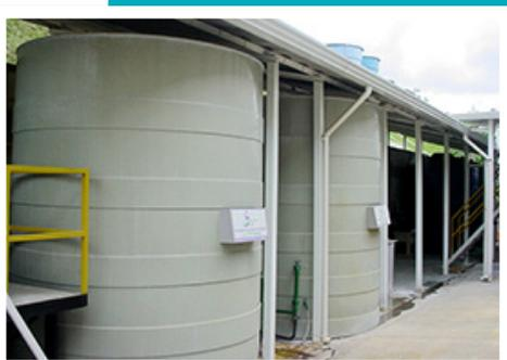
A água utilizada nas lavadoras é encaminhada para um reservatório antes de ir para a ETE, onde é feita a decantação com reatores e produtos químicos.
