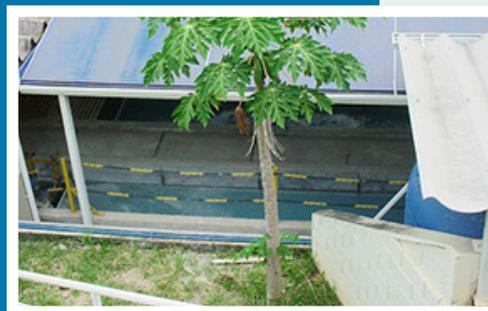
A água com o pó de vidro resultante da lapidação é encaminhada para um reservatório, onde um misturador e produtos químicos fazem a decantação. A água limpa volta para a linha de produção.
